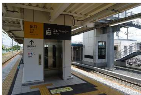
エレベータ（倉見駅）
